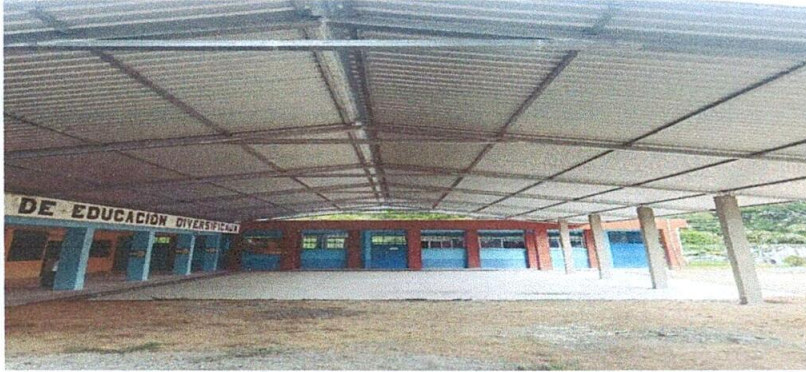
Foto1: TECHADO DE LOSA: Finalización de techado de losa del centro educativo en beneficio de la comunidad educativa.
